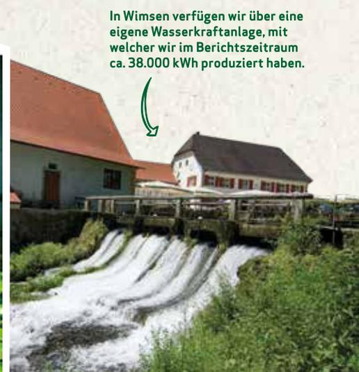
In Wimsen verfügen wir über eine eigene Wasserkraftanlage, mit welcher wir im Berichtszeitraum ca. 38.000 kWh produziert haben.
